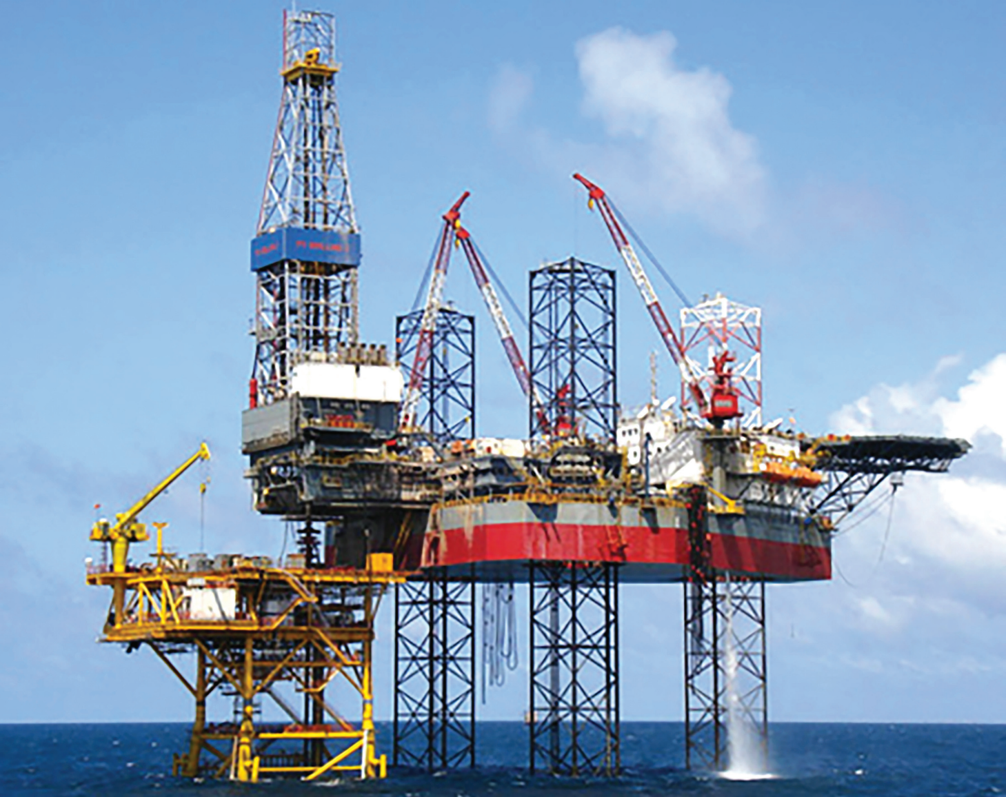
Giàn khoan tự nâng 90m nước của Tập đoàn PVN
